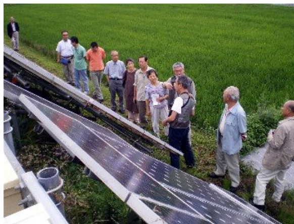
田んぼの太陽光発電所
